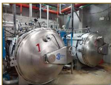
ติดตั้ง Water Spray Retort
